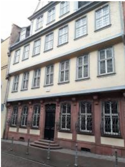
Abbildung 4: Adresse Große Hirschgraben 23-25, 60311 Frankfurt am Main (Quelle: eigene Aufnahme 2023)
